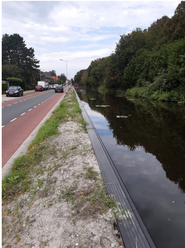
Vervangen damwand Meerweg
